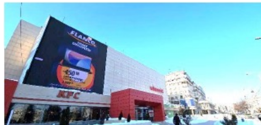
Videowall installato sulla facciata di Ploiesti Omnia Shopping Centre
