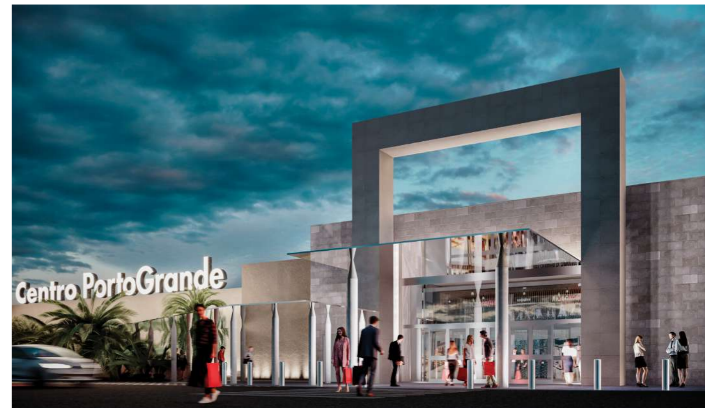
Porto Grande - San Benedetto del Tronto - Ingresso principale
