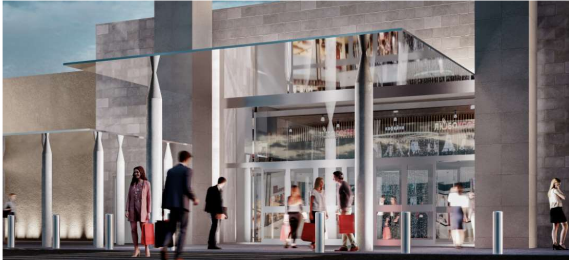
Porto Grande – San Benedetto del Tronto – Ingresso principale
