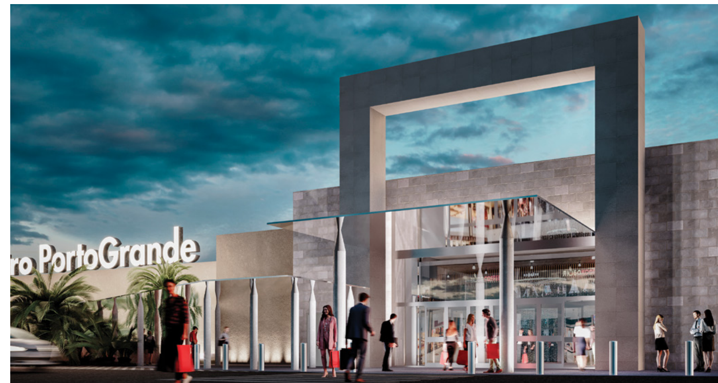
Porto Grande - San Benedetto del Tronto - Ingresso principale
