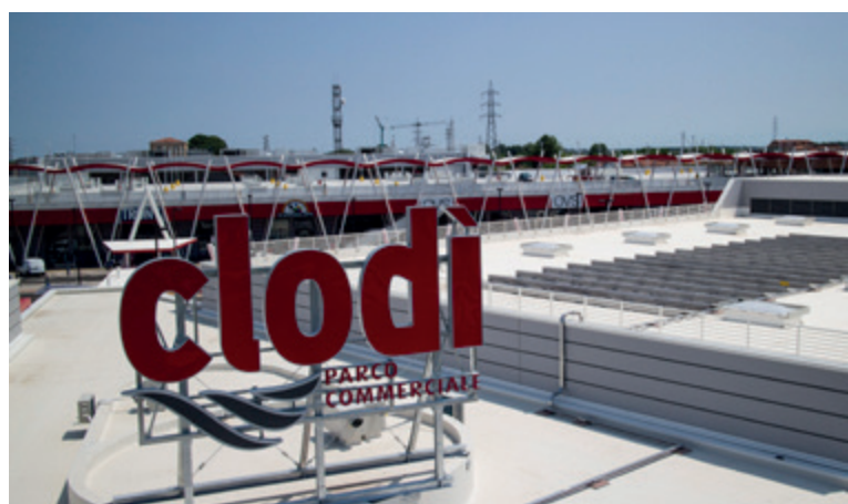
Chioggia (VE) Clodi_Impianto fotovoltaico
