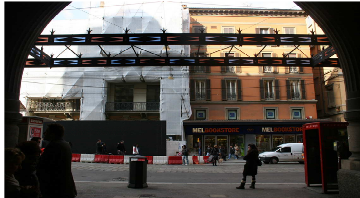
Durante i lavori
