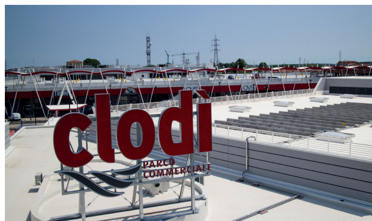
Chioggia (VE) Clodi_ Photovoltaic system
